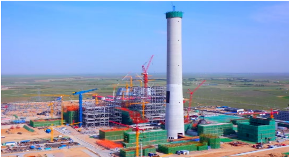
图 9-4 某火电厂 5G 专网项目
